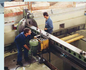
▲ Platinas de réception dans fondation
