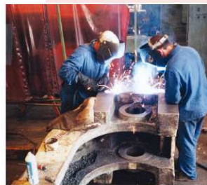
▲ Réparation d'un coulisseau de presse
